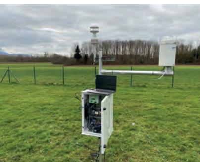
Wetter- und Bodenfeuchtemessstation im Wasserschutzgebiet Landmatt während Installation und Betrieb. (Foto: T. Degenhardt, KIT)
