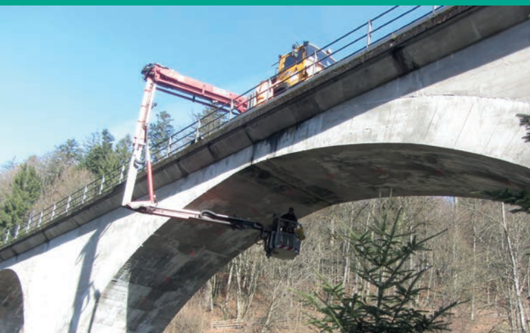
Infrastruktur erhalten: Laufenmühlen-Viadukt. (Foto: T. Bürkle, IONYS AG)
